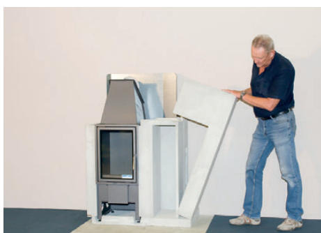
Jednotlivé díly stačí poskládat dle přiloženého návodu. Upevněte akrylátovým lepidlem. (4 + 5)
