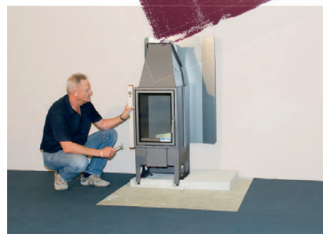
Ustavte krbovou vložku pomocí vodováhy. (3)
