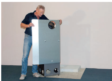
Namontujte protipožární ochranu na krbovou vložku (zvláštní příslušenství). (2)
