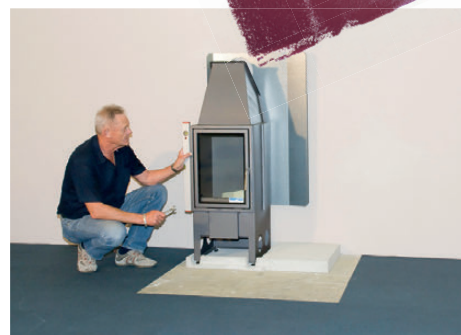
Ustavte krbovou vložku pomocí vodováhy. (3)
