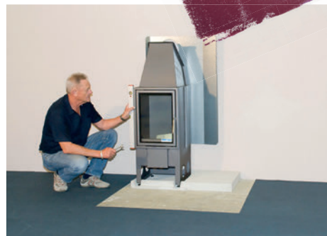
Ustavte krbovou vložku pomocí vodováhy. (3)
