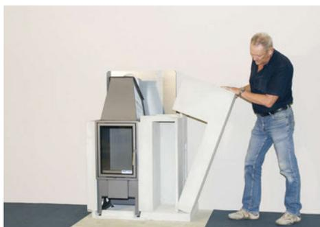
Jednotlivé díly stačí poskládat dle přiloženého návodu. Upevněte akrylátovým lepidlem. (4 + 5)
