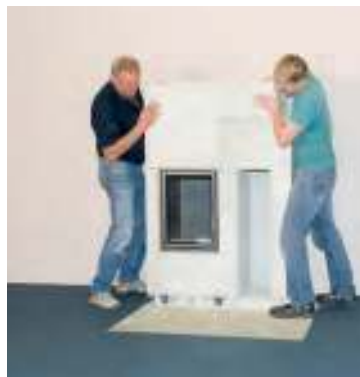
Jednotlivé díly na sebe skládat krok za krokem dle návodu a upevnit pomocí akrylového lepidla
