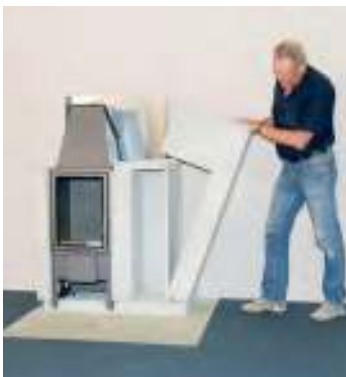
Jednotlivé díly na sebe skládat krok za krokem dle návodu a upevnit pomocí akrylového lepidla
