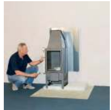
Ustavit krbovou vložku pomocí vodováhy
